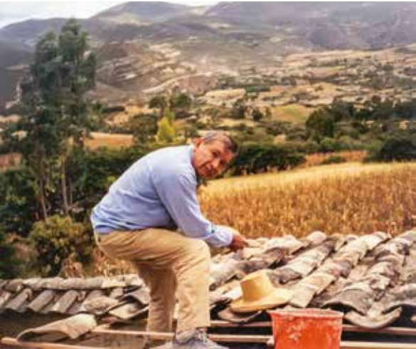
1982. Enrique Galdos Rivas arreglando el techo de su taller en Ichocán, Cajamarca. 1982. Enrique Galdos Rivas fixing the roof of his atelier in Ichocan, Cajamarca.
